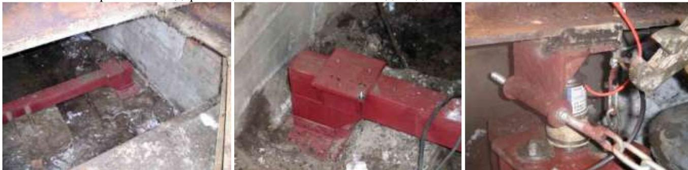
Специальные металлоконструкции устанавливаются в штатные места фундамента вместо опорных тумб рычажного механизма.
